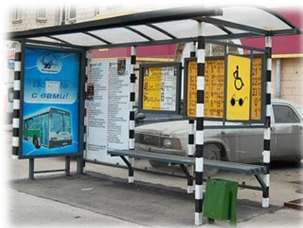
Рис. 1. Автобусная остановка в г. Мытищи, оборудованная для людей с ограниченными возможностями
